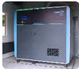
Energiespeichereinheit (ESS) & Wasserstoff Produktions- und Verstromungseinheit.
